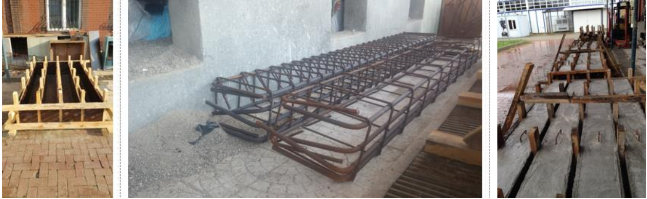
Şekil 4. Numunelere ait kalıp, demir, beton imalatı
